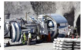
TBM abierta, Alto Maipo
